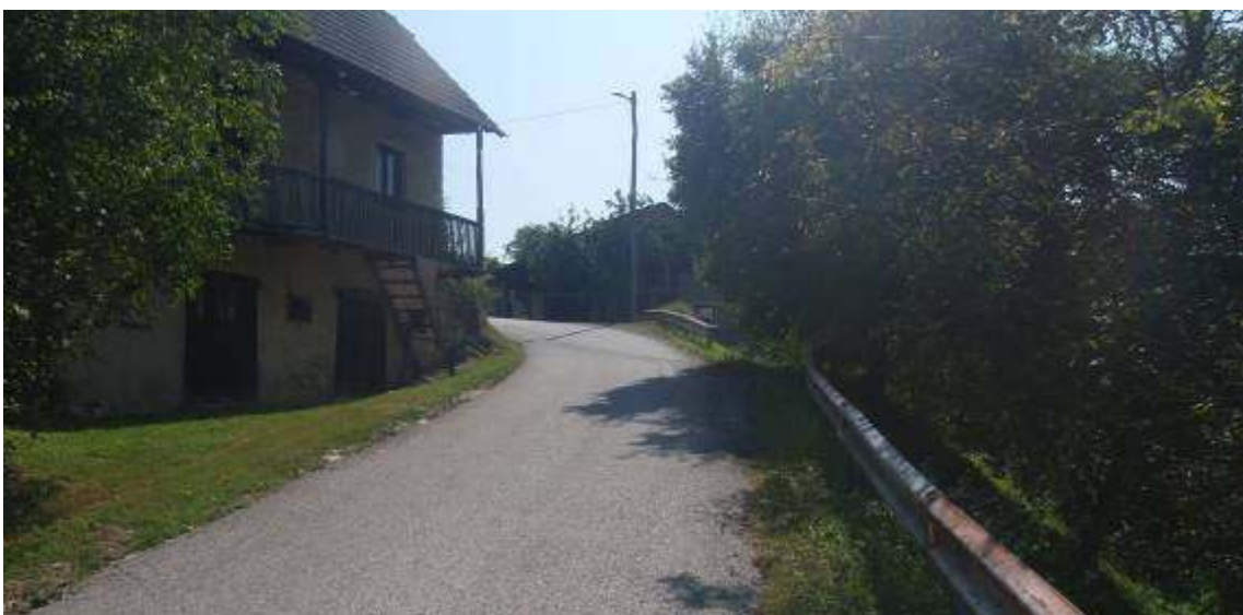
Slika 5: Pogled v smeri poteka po lokalni cesti, kjer je na levo objekt, ki se ruši, desno pa večja nasipna brežina
