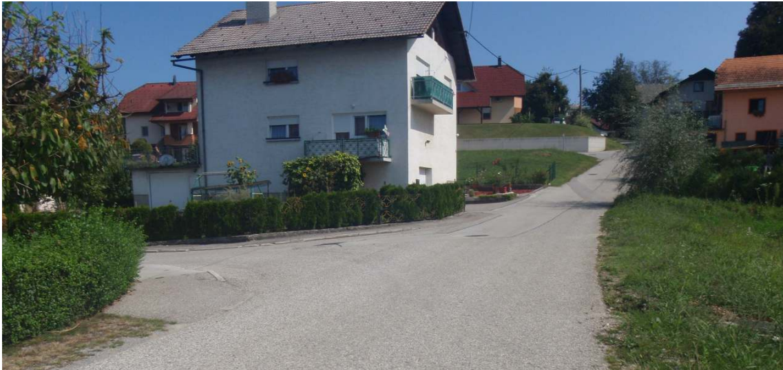
Slika 6: Pogled na zadnji del lokalne ceste, kjer je na desni predvidena nova pozidava
